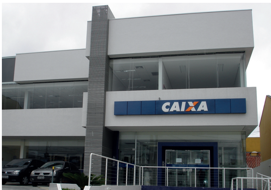
PBE Edifica: Agência Caixa Econômica Federal (PR)
