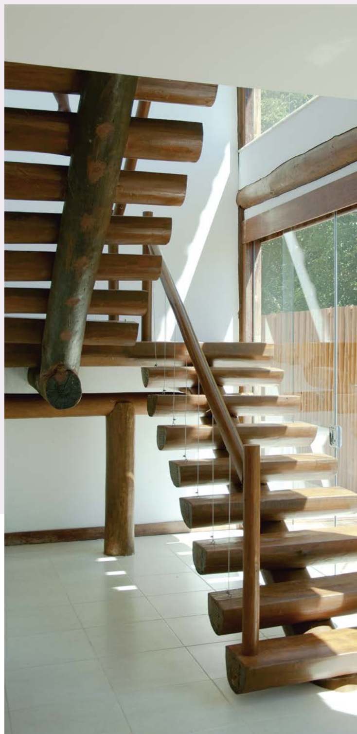
A viga central que sustenta os degraus de tora de eucalipto faz da escada uma obra de arte. Destaque para o fechamento do corrimão, feito com cabos de aço
