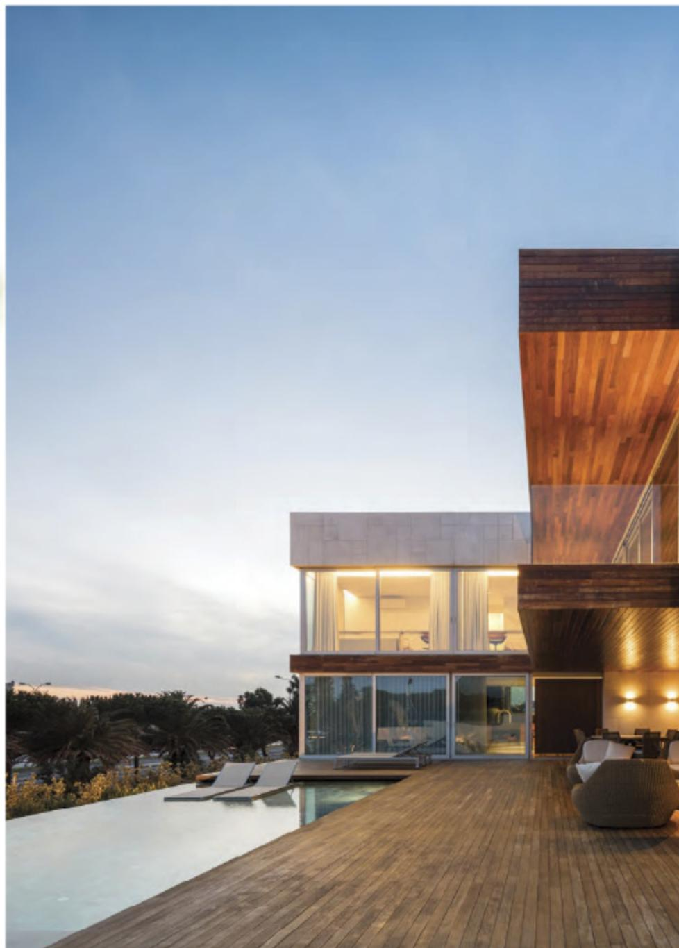
A piscina feita de concreto armado possui 39,15 m², prainha de 0,30 m de profundidade e o tanque para banhos atinge 1,50 m. No interior, a estrutura foi revestida com pedra hijau lisa, na cor verde e no tamanho 10 x 10 cm. Ao redor, foi usada a mesma pedra na versão bruta. A borda infinita cria um efeito contínuo com a paisagem.
