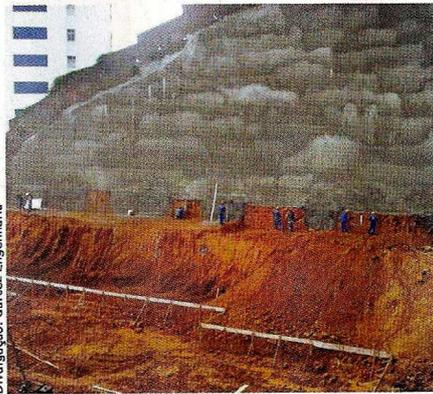
A altura da contenção variou de 3 m até 32 m, em solo grampeado. Inclinômetros foram implantados para medir a variação do maciço do solo
