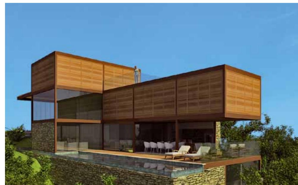
Projetada pelo escritório SQ+ Arquitetos Associados, a casa com estrutura metálica é constituída por três módulos, com destaque para a ala social, composta pelas salas de estar e jantar, espaço gourmet e varanda. O terreno, com declive acentuado, motivou a construção dessa área no subsolo, que se situa 3 m abaixo do nível da rua. No pavimento, a piscina e um espelho d'água abraçam a morada e promovem a sensação de ter um living sobre a água.
